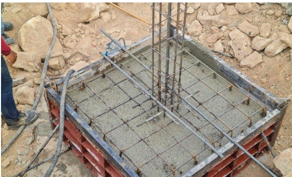
Betons ar armatūru
