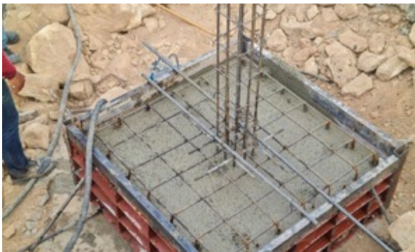
Beton zbrojony prętami stalowymi (prętami zbrojeniowymi)
